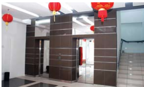
Infinite Centre 的新电梯
