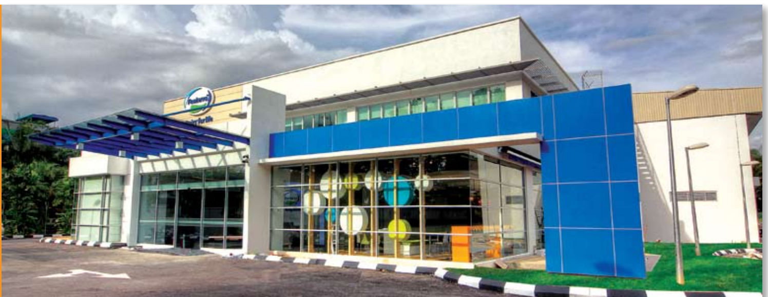
改造后的 Fonterra 总部外观
